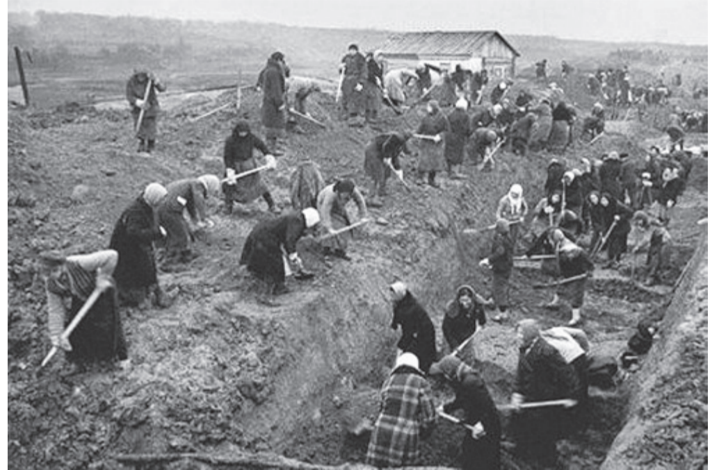
Август 1941 года. Гражданское население на строительстве противотанковых рвов. 13-15 октября многие из них будут похоронены в этих рвах
